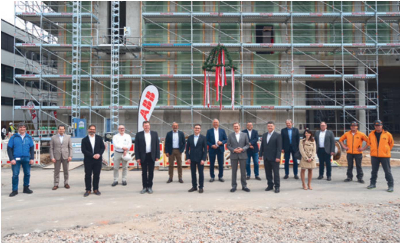
Richtfest für das Innovationszentrum ABB Campus in Mannheim-Käfertal. Foto: ABB / Andreas Henn
