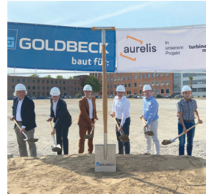
Spatenstich für das Parkhaus im Turbinenwerk Mannheim. Foto: Aurelis Real Estate
