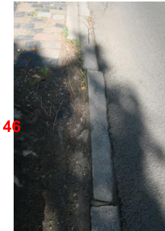
Bild 11: Zeigt den in die Straße gedrückten Bordstein durch Baum Nr. 46
